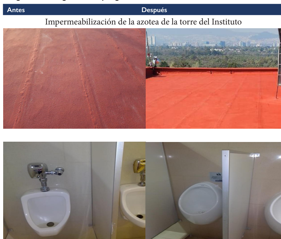
Cambio de mingitorios en los baños de la torre del Instituto
